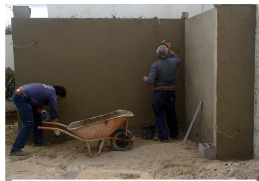
Construção de muro Escola EBI Montinho da Cotovia
